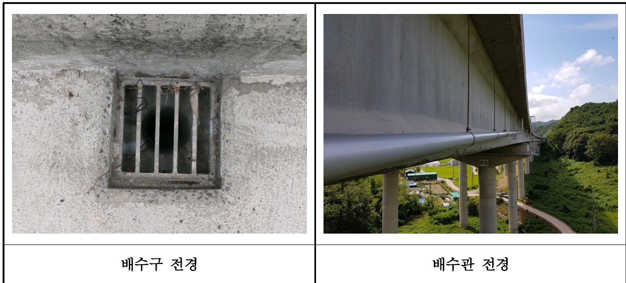
【사진 11.3.49】 배수시설 전경
