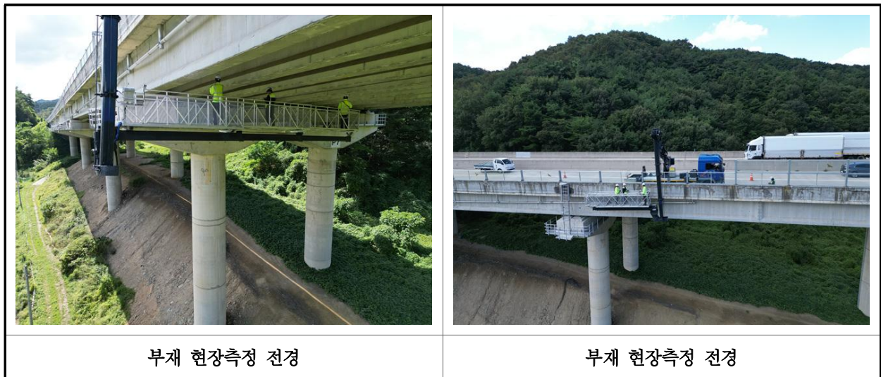
【사진 11.2.1】 부재 현장측정 전경
