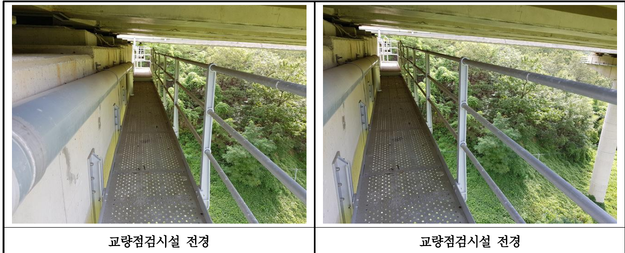
【사진 11.3.53】 교량 점검시설 전경
