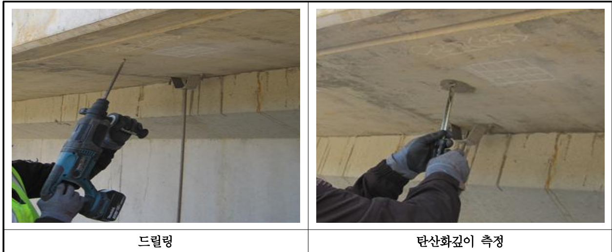
【사진 11.4.3】 탄산화 깊이 측정 현장사진
