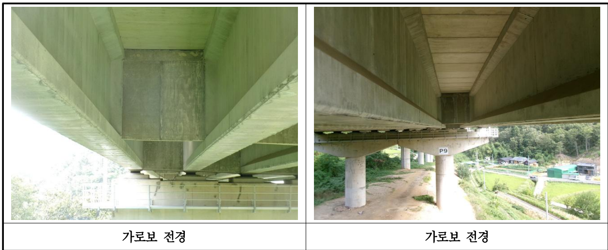
【사진 11.3.6】 가로보 전경
