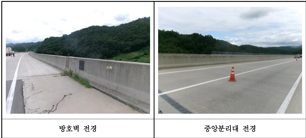
【사진 11.3.51】 방호벽 및 중앙분리대 전경
