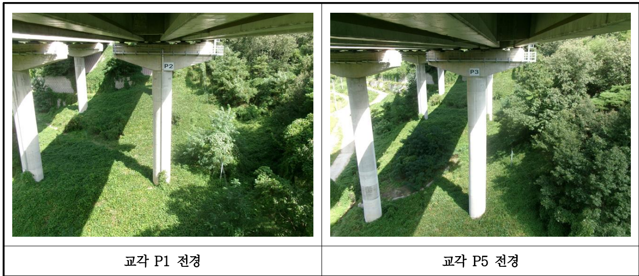
【사진 11.3.10】 교각 전경
