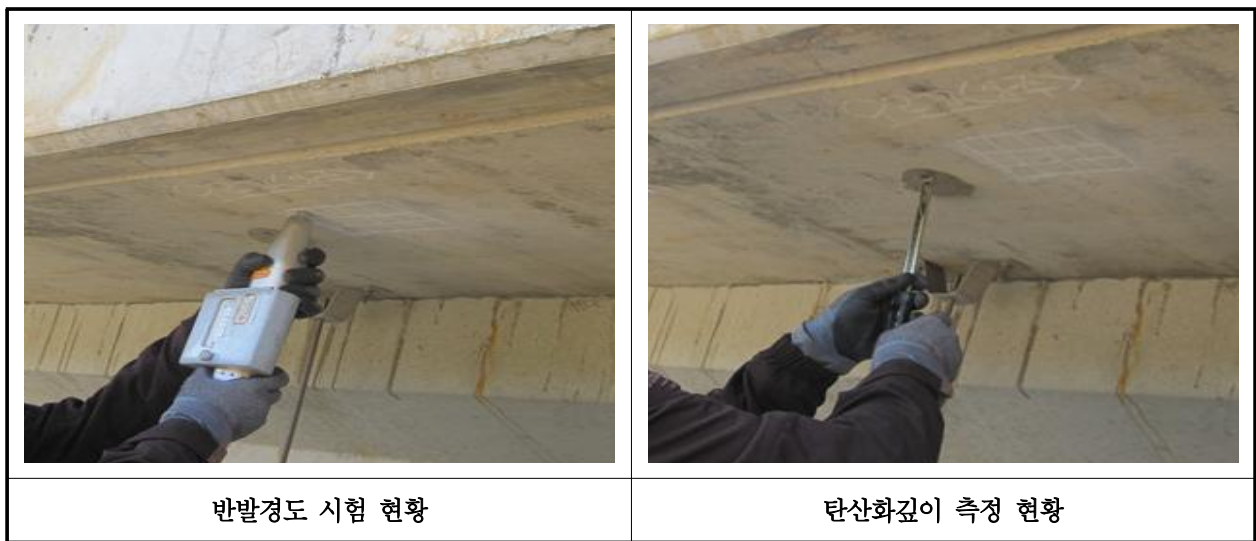
【사진 11.4.1】 콘크리트 내구성조사 현황
