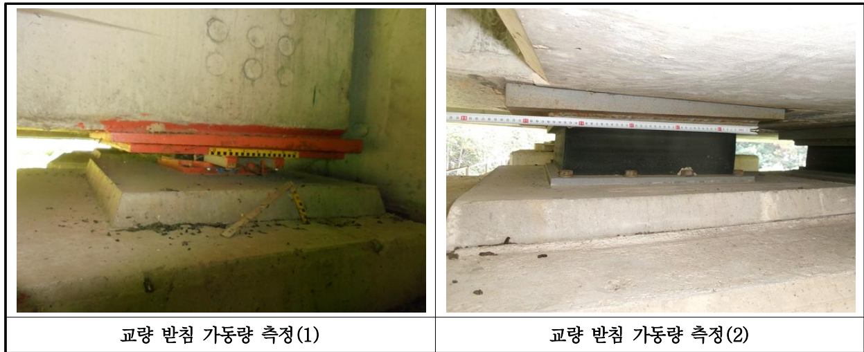
【사진 11.3.16】 교량받침 이동량 측정
