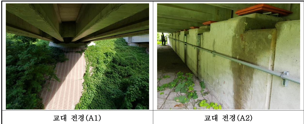
【사진 11.3.35】 교대 전경
