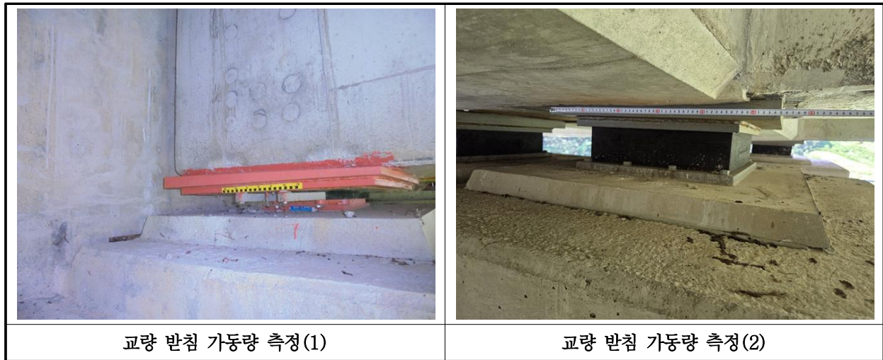
【사진 11.3.43】 교량받침 이동량 측정
