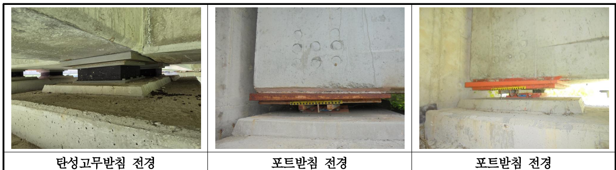
【사진 11.3.40】 교량받침 전경
