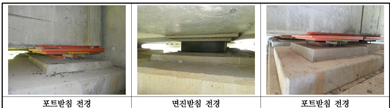
【사진 11.3.13】 교량받침 전경
