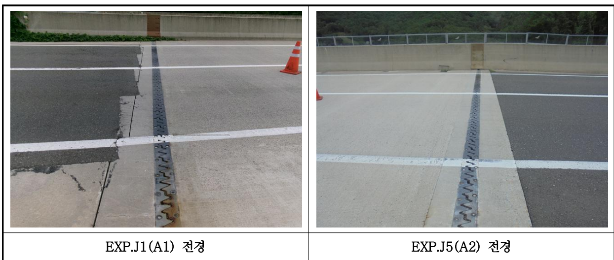
【사진 11.3.44】 신축이음장치 전경
