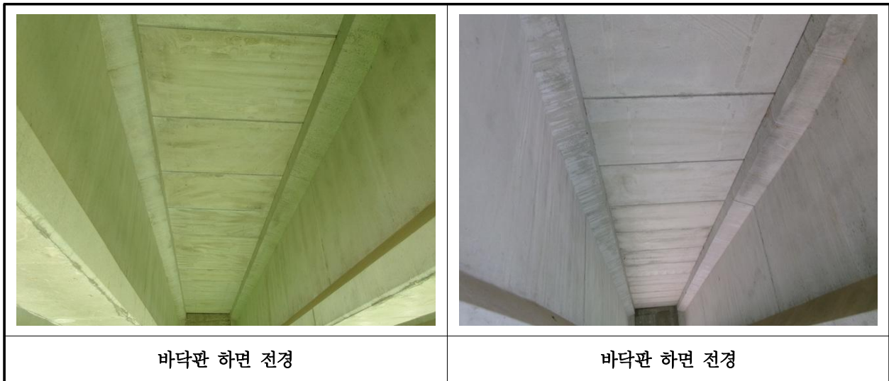
【사진 11.3.2】 바닥판하면 전경
