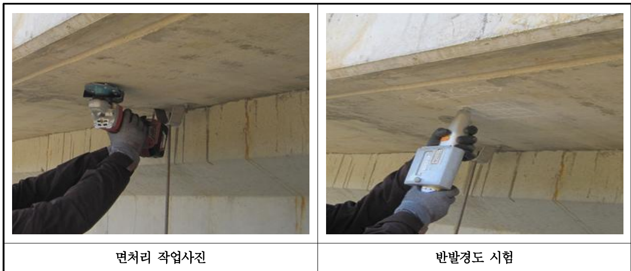
【사진 11.4.2】 반발경도시험 현장사진
